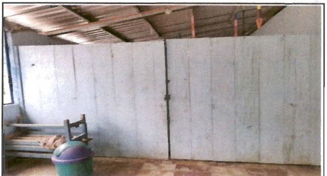
Foto 4: Remozamiento de división existente
