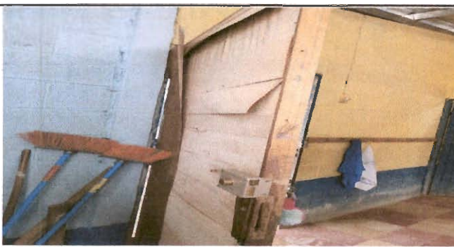
Foto 5: Sustitución de puertas de madera en mal estado
