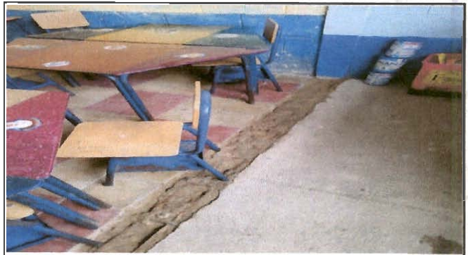
Foto 2: Reparación de piso en aulas y corredores
