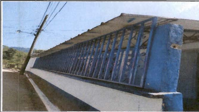
Foto 1: Colocación de canales y bajadas de agua
