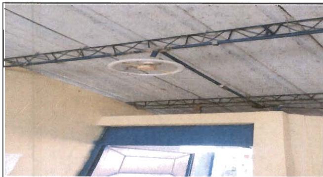
Foto 9: sustitución de lámparas
