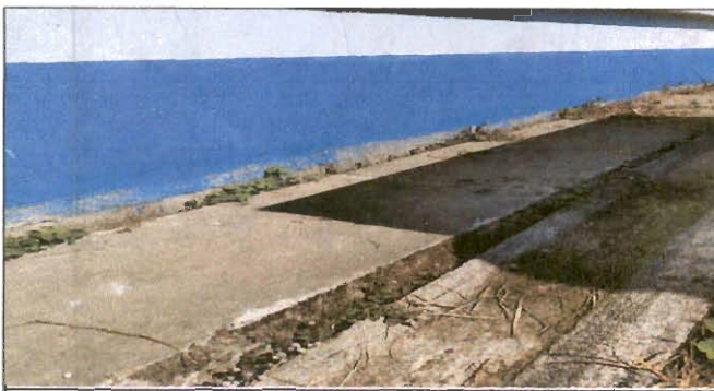
Foto 11: Remozamiento de banqueta
